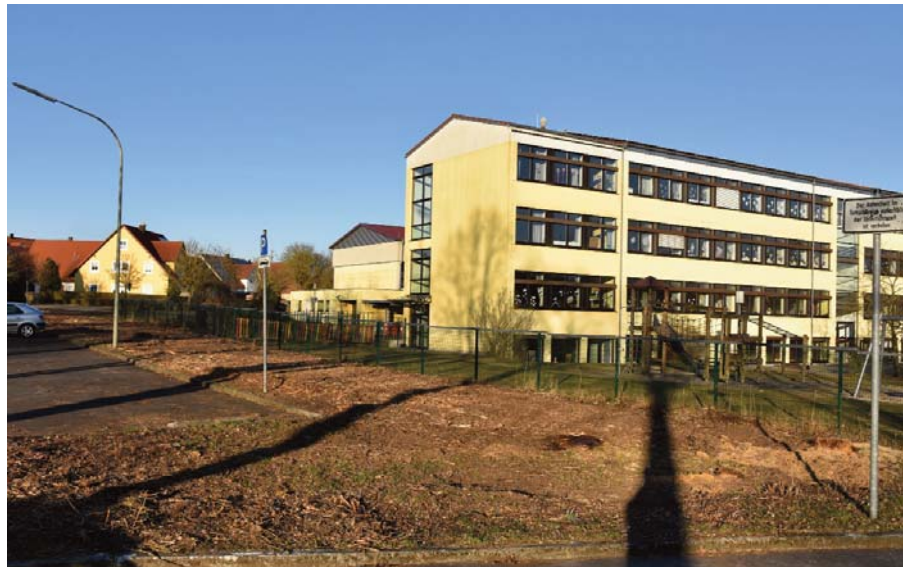
An dieser Stelle wird ein eingeschossiger Bau für die Betreuung errichtet.
